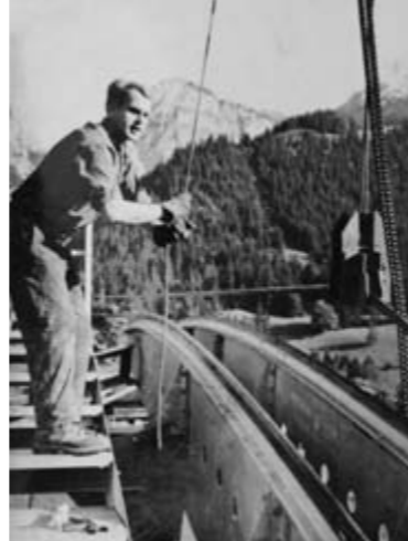
Walter Baumann (Betriebsleiter bis 2002) als Seilbahnmonteur der Von Roll AG
